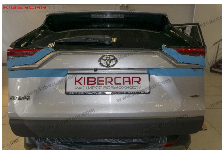
Рисунок 2 – Защита элементов багажного отделения и кузова автомобиля
