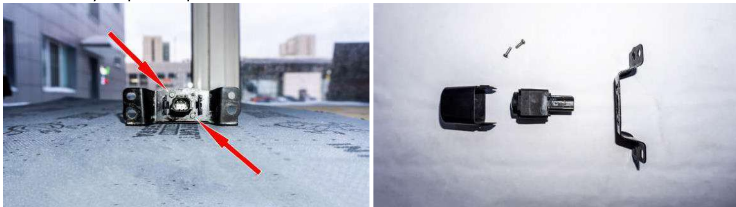
Рисунок 5 – Расположение винтов крепления
